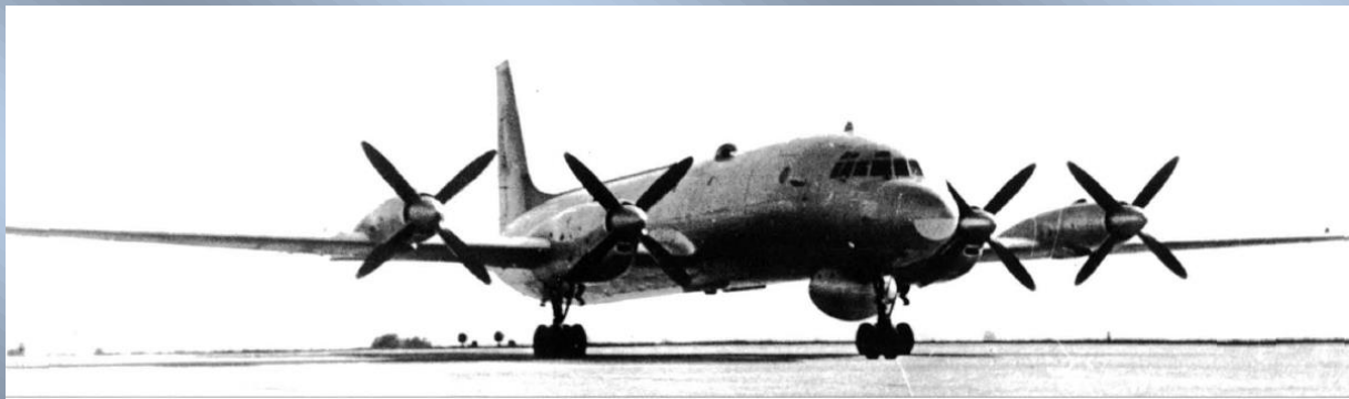
A prototípus kezdetben nem rendelkezett a Berkut-rendszer elemeivel, mégis kialakították a radar és a MAD-szenzor áramvonalazott burkolatát az aerodinamikai tesztek gyorsabb lefolytatása végett
