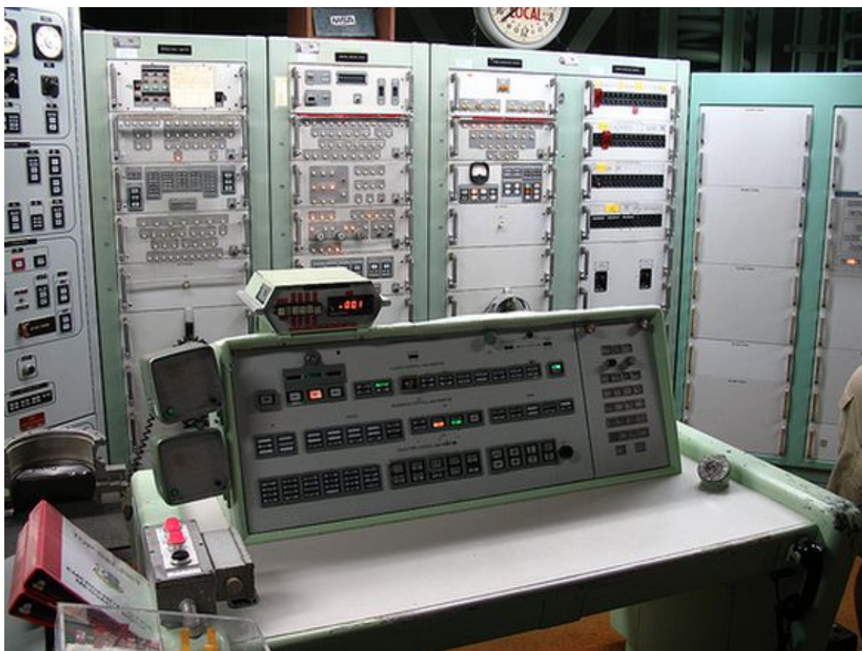
Kilövés vezérlő panel
